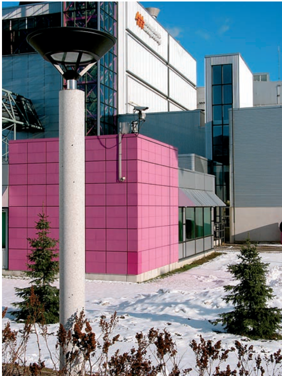
Vuosaaren A-voimalaitoksen sisäänkäynti. Helen Oy
