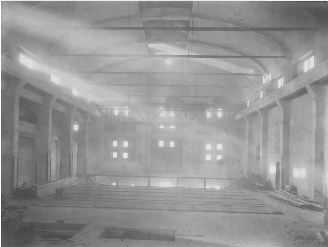
Suvilahden voimalaitoksen turbiinihalli betonivalutöiden valmistuttua. Helen Oy
