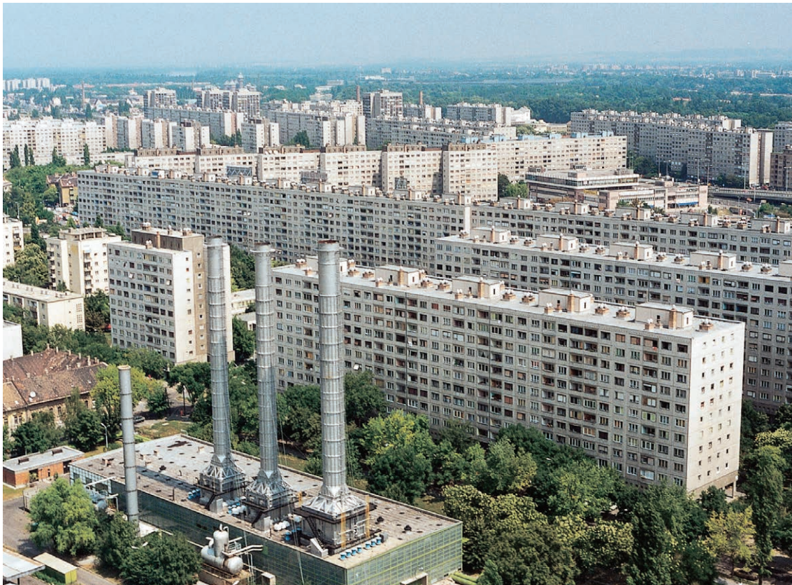
San Marcon kaukolämpölaitos Budapestin esikaupungissa 2005. Főtáv Zrt
