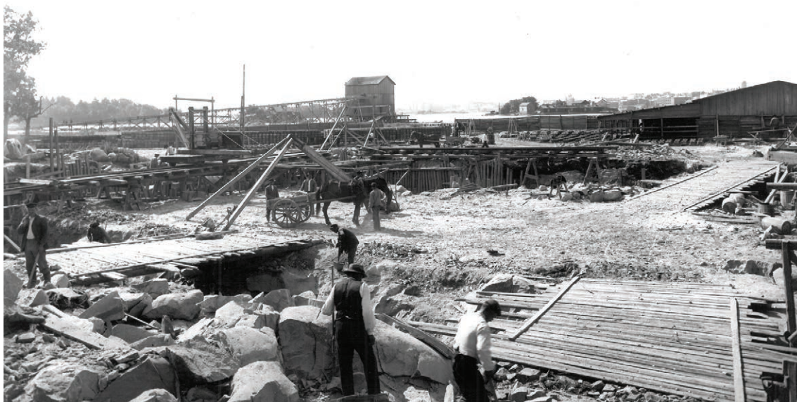
Suvilahden voimalaitoksen perustuksia kaivetaan vuonna 1908.
