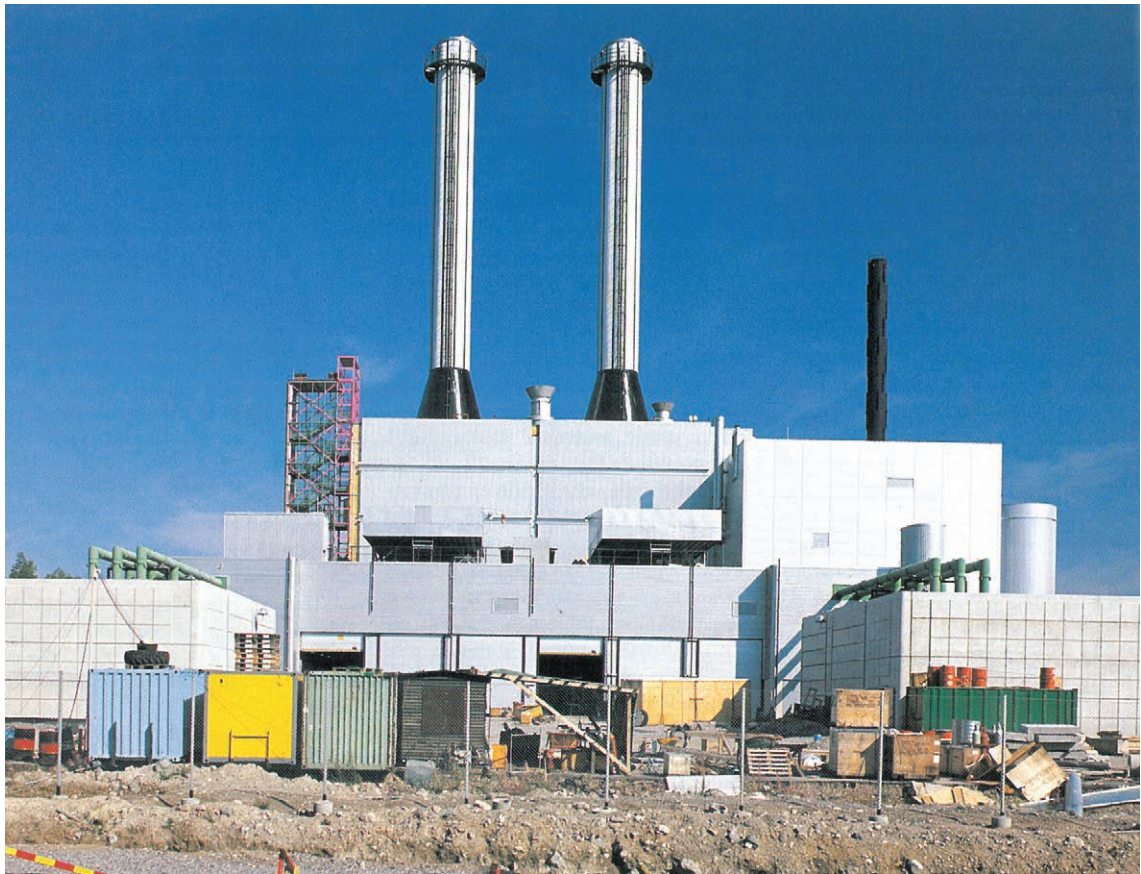
Vuosaaren A-voimalaitos rakenteilla vuonna 1990. Helen Oy
