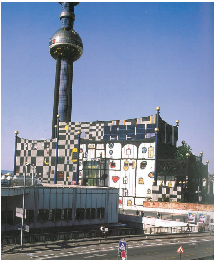
Spittelaun voimalaitos 2005. Fernwärme Wien GmbH
