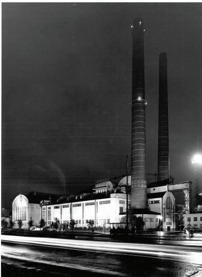
Suvilahden voimalaitos Sörnäisten rantatiellä iltavalaistuksessa. Helen Oy
